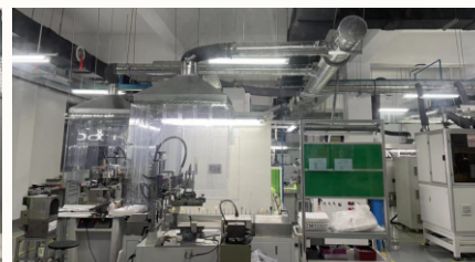
打样车间废气处理设施
